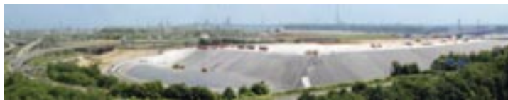
Der Bereich innerhalb des Autobahnkreuzes Leverkusen-West wird großflächig mit Kunststoffdichtungsbahnen (Flachbereiche) und Asphalt (Böschungen) abgedichtet.
