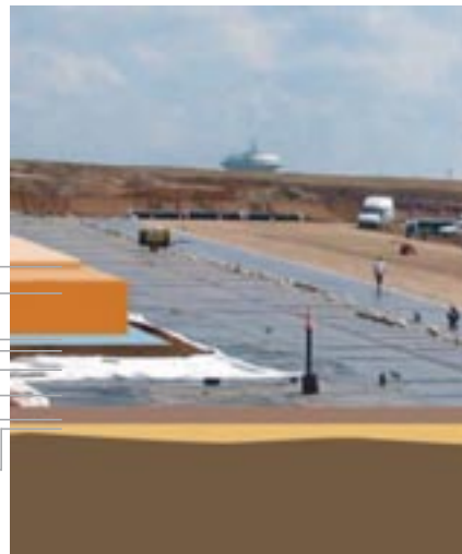
Aufbau der Oberflächenabdichtung Dünnaue-Nord
